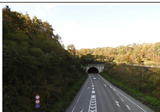
ヤマネ・トンネル （清里高原道路・清里トンネル）
