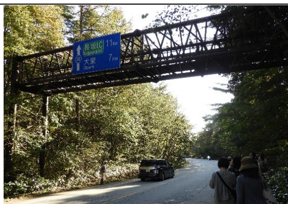
ヤマネ・ブリッジ（県道28号）
