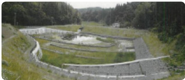
環境保全型調整池（圏央道 茂原地区）
